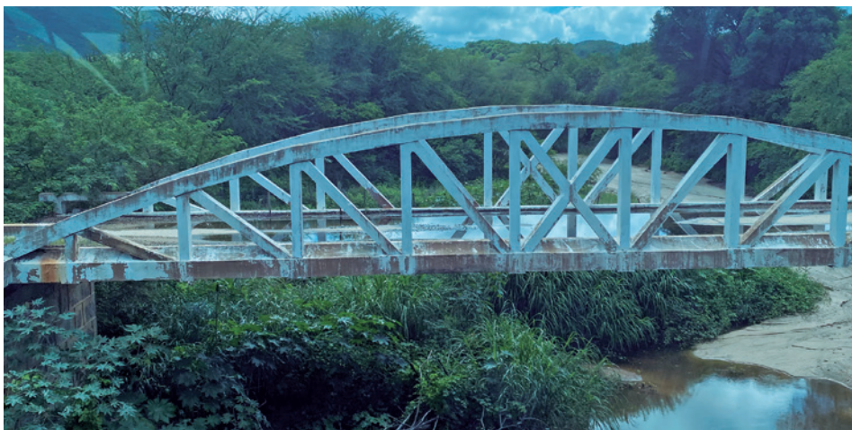
Túnel em sítio arqueológico (no alto) e a maior ponte férrea do NE, na Serra da Viração
